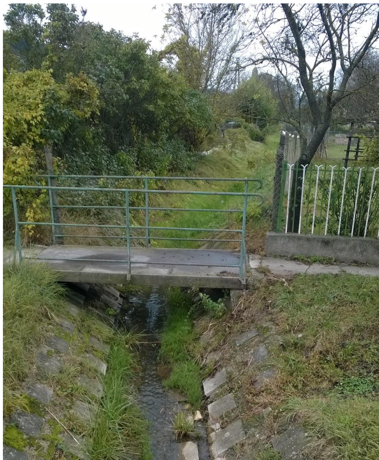
4. kép: Bendola-patak, Litér, Templom utca felvíz
