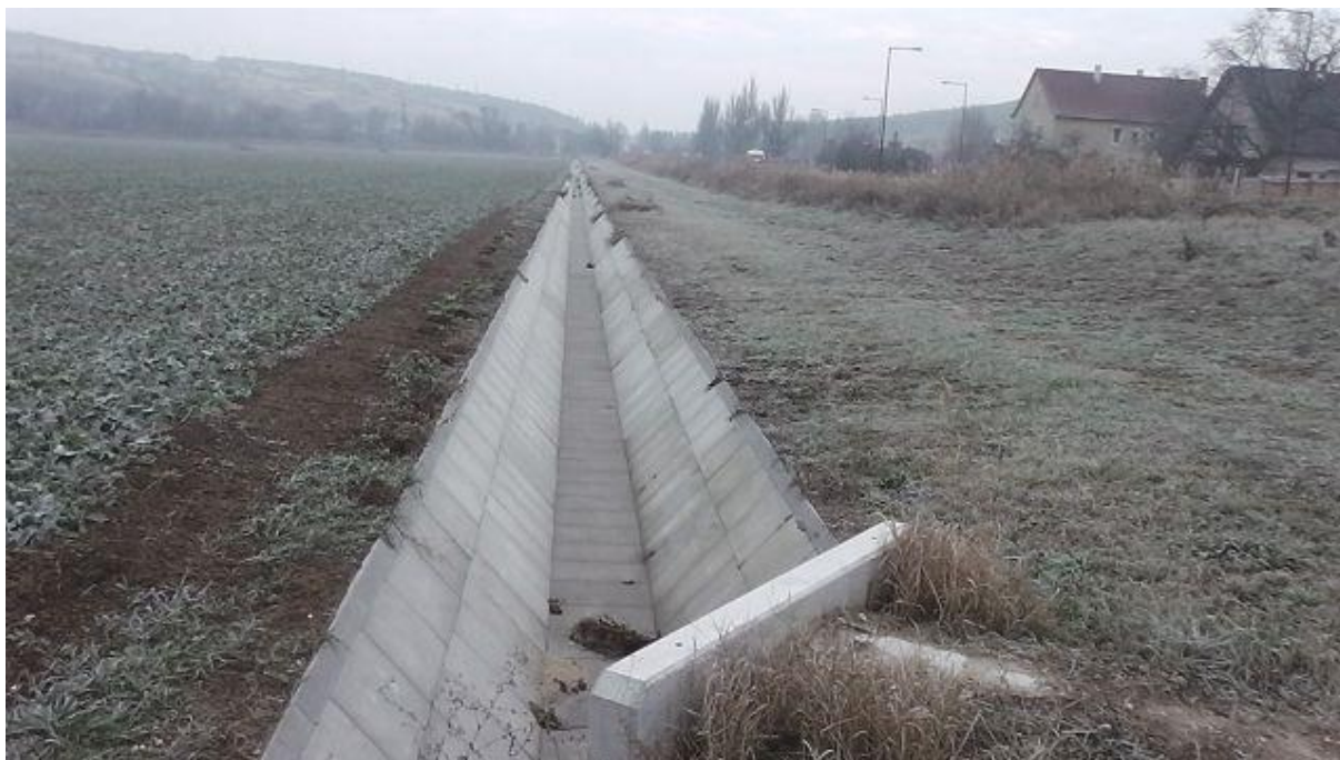
4. kép: Új levezető árok a 72. sz. főút árkával párhuzamosan
