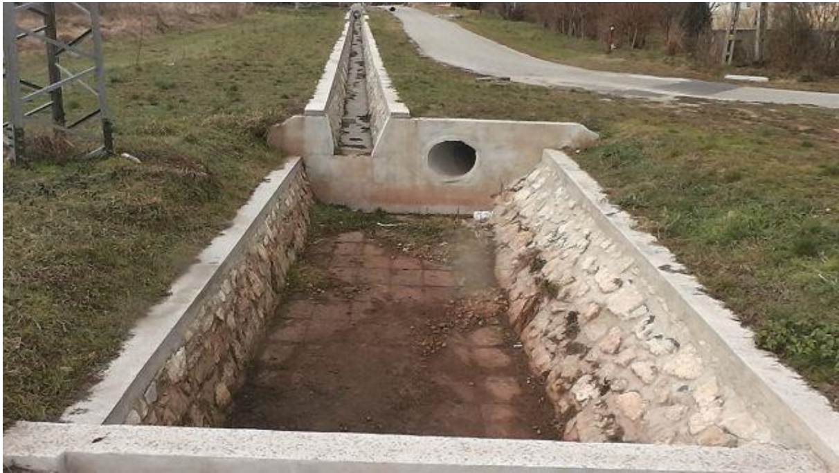
7. kép: A Patak utcai nyílt árok a sankolótérrel.
