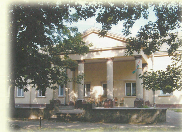
Az Árpád Fejedeleme Általános Iskola a felújított kastély épületében
