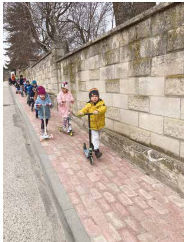
Biztonságos közlekedést tesz lehetővé a felújított járda
