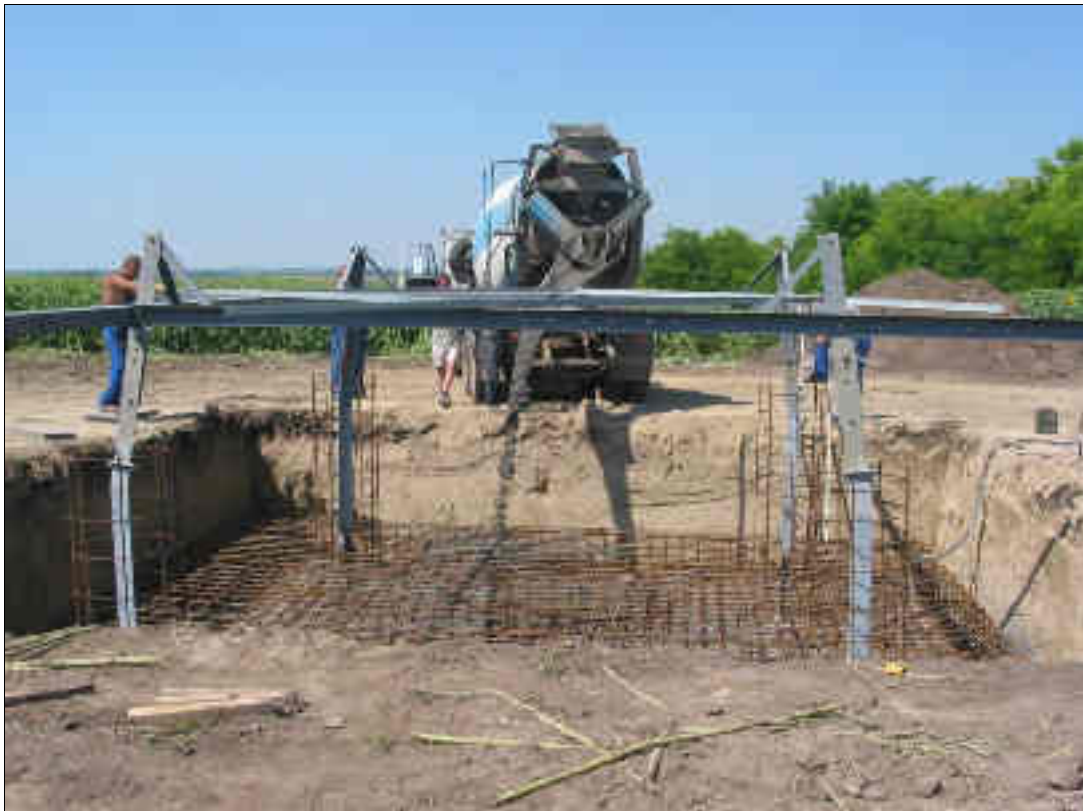
2.2.2. ábra: Alapozási munkálatok a távvezetékoszlopok kiépítésénél – illusztráció (forrás: ELINOR Kft.)
