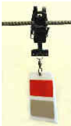
5.4.5. ábra: Madárriasztó berendezés légvezetéken (forrás: http://www.mme.hu )
