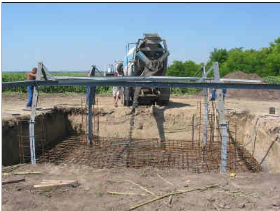
2.2.3. ábra: Alapozási munkálatok a távvezetékoszlopok kiépítésénél – illusztráció (forrás: ELINOR Kft.)
